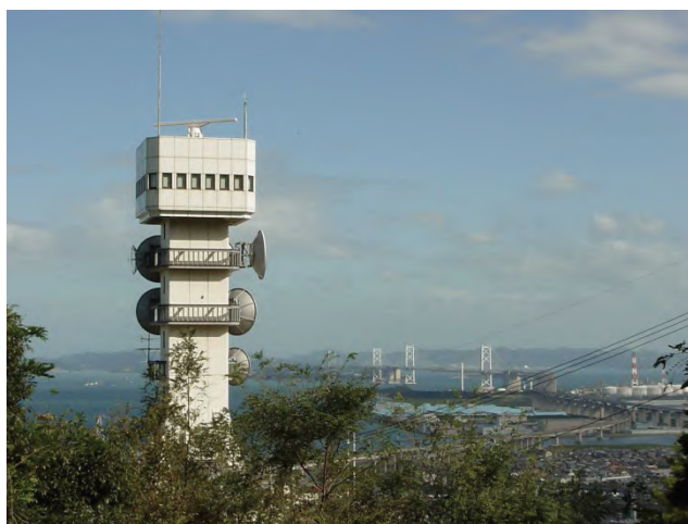
図 1 2 備讃瀬戸海上交通センター
