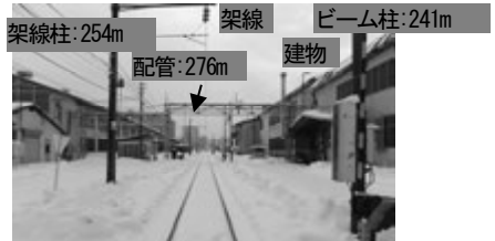
図9 仰角の悪い箇所
