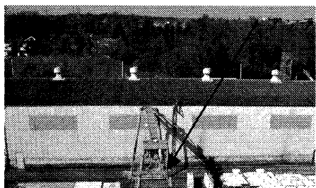
図-6 移動体の観測例（その1） クレーンに取り付けた GPS によって観測を行った。
