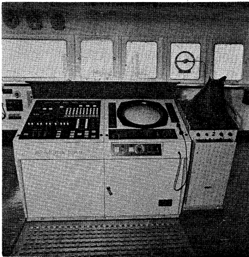
写真 1 星光丸の衝突予防システム表示装置
