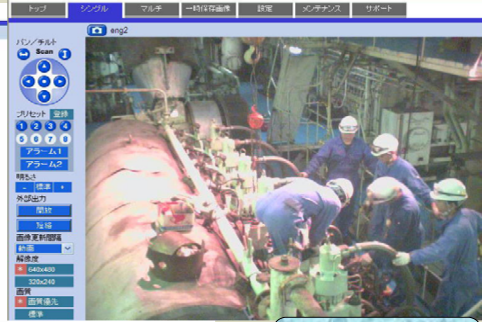
機関室作業状況
