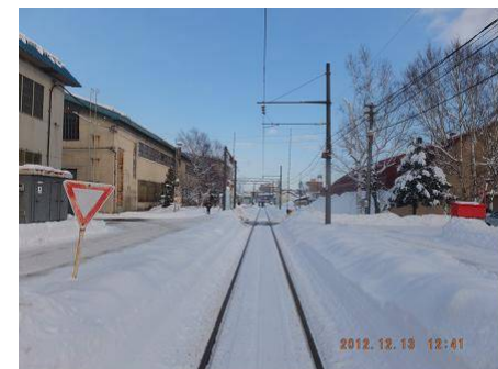
(下) 241mから開始地点側の状況
