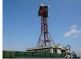
川崎港内交通管制室(塩浜)
