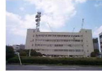
千葉港内交通管制室(千葉)
