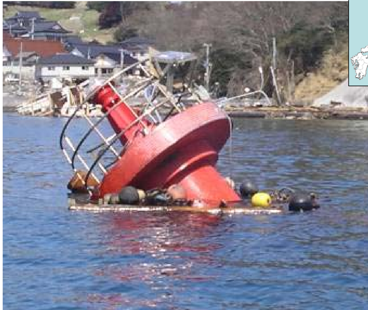
防波堤先端部が倒壊し、水没した灯台 【大船渡港長崎東防波堤灯台（岩手）】
