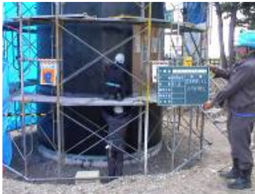
耐震化整備 (炭素繊維シートによる補強)
