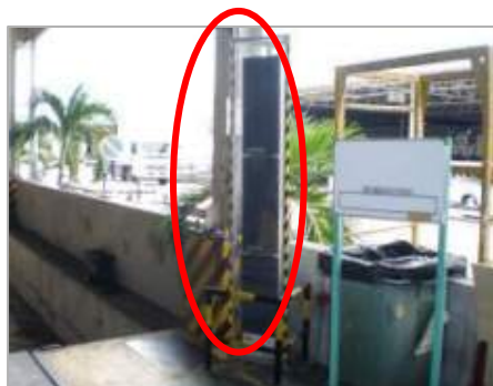
ドックへのRFID リーダの設置
