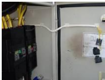
引き込み盤の接地端子スパーク痕跡
