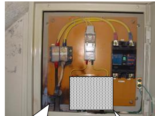
保護素子焼損による被害
