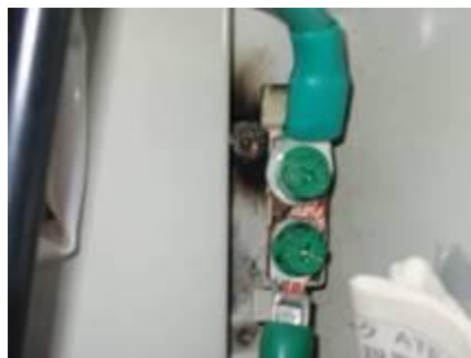
引き込み盤の接地端子スパーク痕跡
